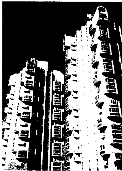
Общий вид 22- и 25-этажных домов
