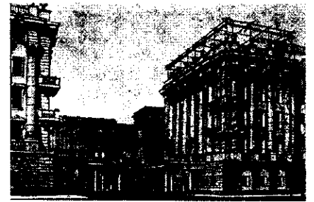
Строящийся жилой дом "Автомобилист" на Ленинградском шоссе. Архитектор Б. Ефимович, 1934 г.
